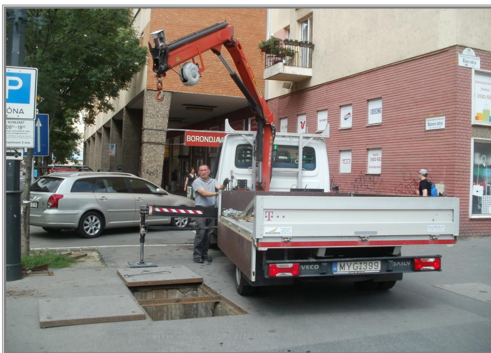
Baross utca és Rigó utca sarkán megnyílt a járda, indult a daru, kezdődött a leletmentés
