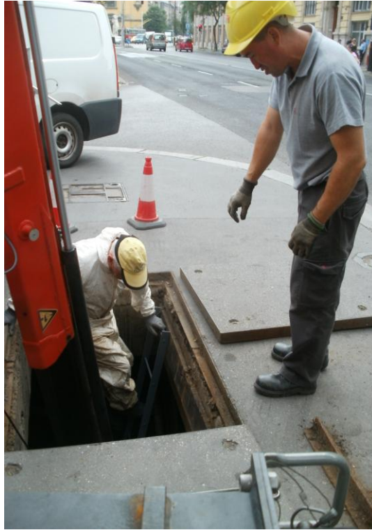
Kezdődik a munka, Balázs indul a föld alá, a sötét, sáros, nyálkás ismeretlenbe
