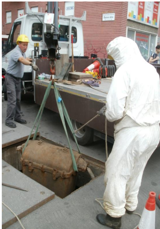
Nyolcvan év után az első „kincs” napvilágra kerül
